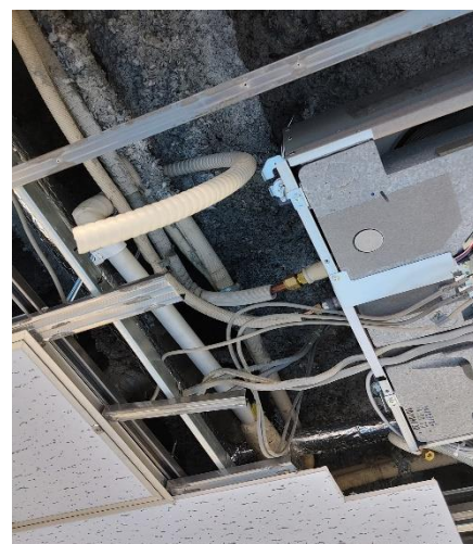
エアコン更新工事イメージ写真
